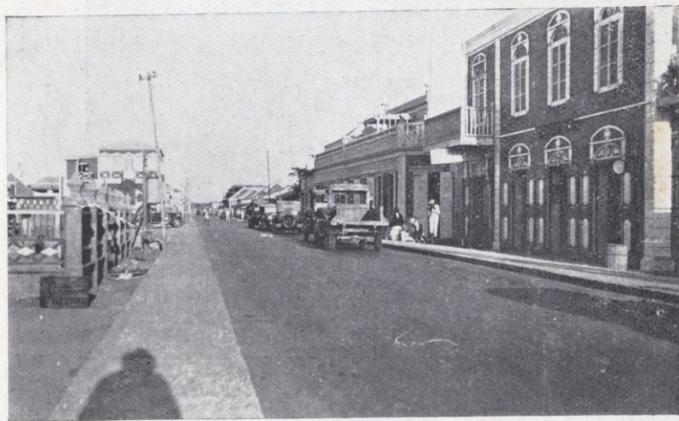
Nassaustraat, Oranjestad, na den aanleg van nieuwe wegen,
